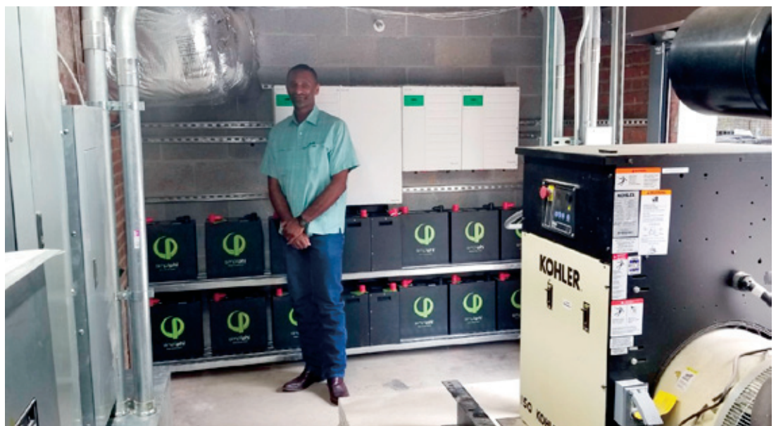
Sistema de batería SimpliPhi de 56 kilovatios-hora en Maycroft Apartments en Washington, DC. Cortesía de SimpliPhi Power
